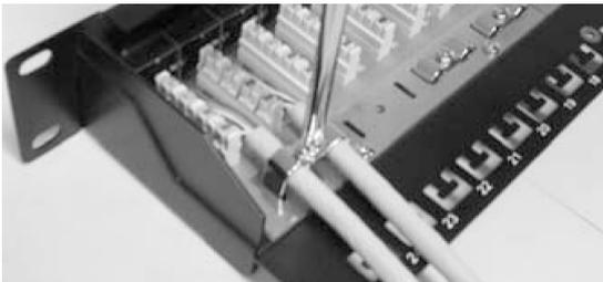
Atornille los tornillos a la carcasa metálica hasta que queden fijos los dos revestimientos de cable al mismo tiempo.
