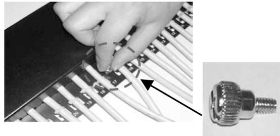
Coloque la tapa metálica en la carcasa inferior y atornille.
